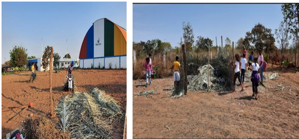
Figura 3: Construção do ‘container’
